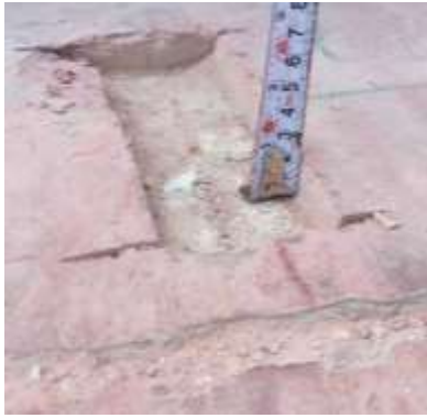
(d) Pockets of size 150 x 50 x 15 mm for accommodating anodes
